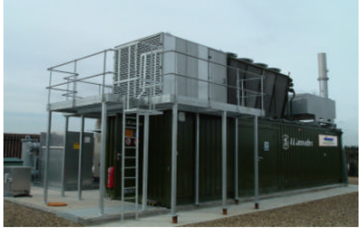
Actual site installation
